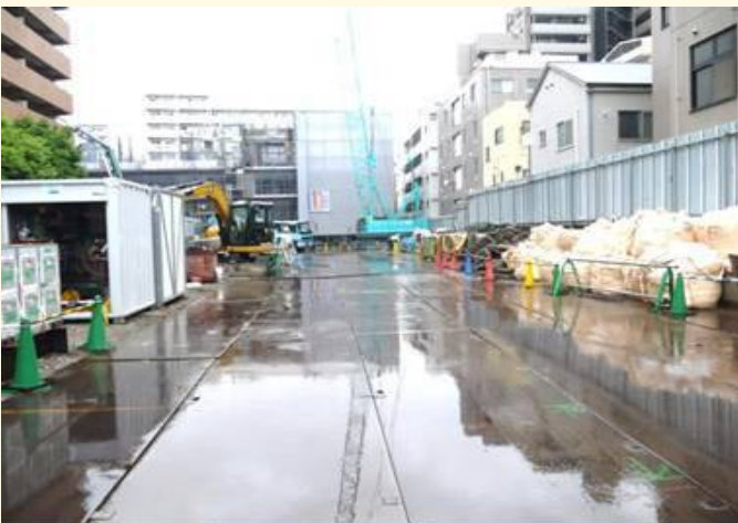
地面采用2cm厚全钢板铺设
