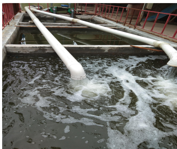
脱硫塔 (循环水)
